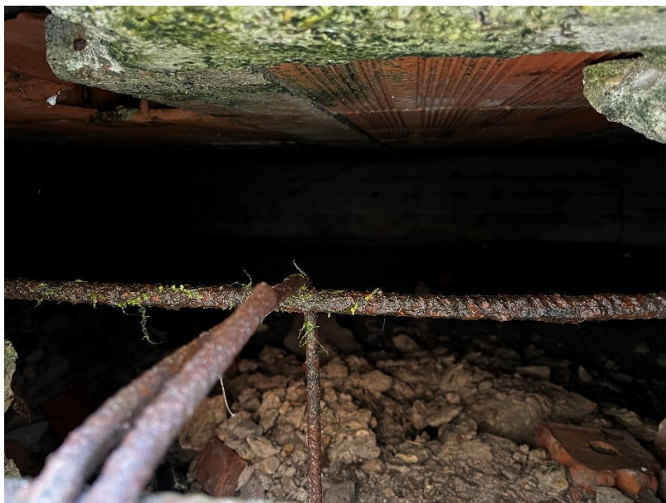
Solaio latero-cementizio di piano terra e armature trave rovescia di fondazione
