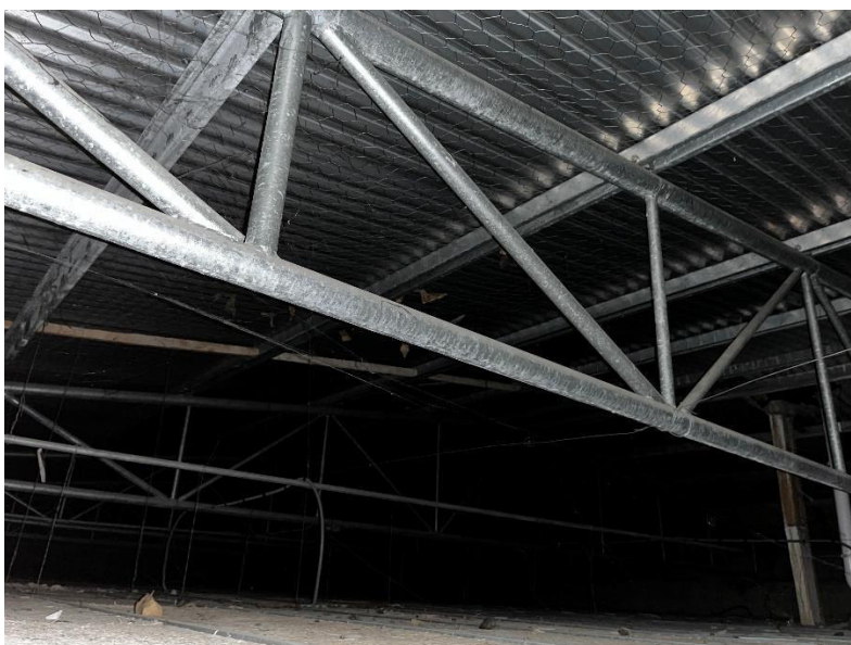
Capriate metalliche di copertura e arcarecci a omega
