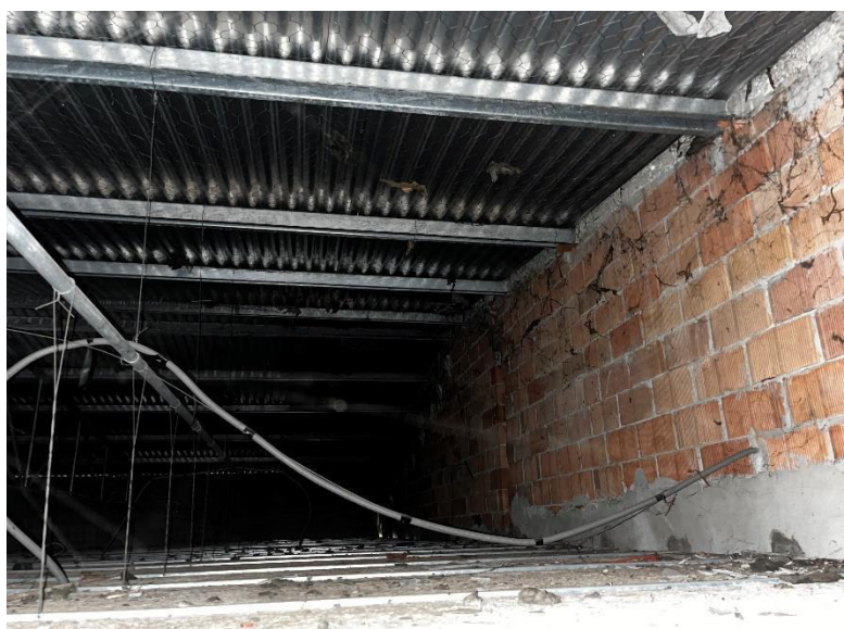
Appoggio Arcarecci a omega su cordolo in c.a. e lamiera grecata
